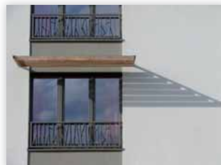
Détail d'un brise-soleil © Atelier de l'Arbre d'Or
