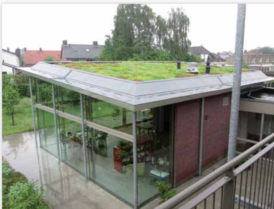
Vue de la Tuinkamer depuis la coursière
