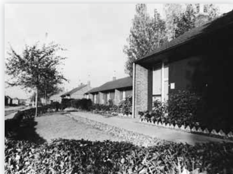
Maisonnettes pour « Vieux travailleurs » (Quaregnon), maître de l'ouvrage « Société des habitations à bon marché de Quaregnon », architectes Jacques Dupuis et Simone Guillissen-Hoa, 1952-1953.
